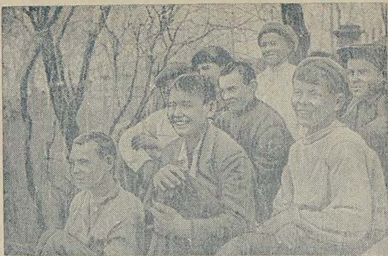
Ученики группы плотников Майковской школы ФЗО производят текущий ремонт сооружений городского парка. На снимке: Минуты отдыха в перерыве от работ.
